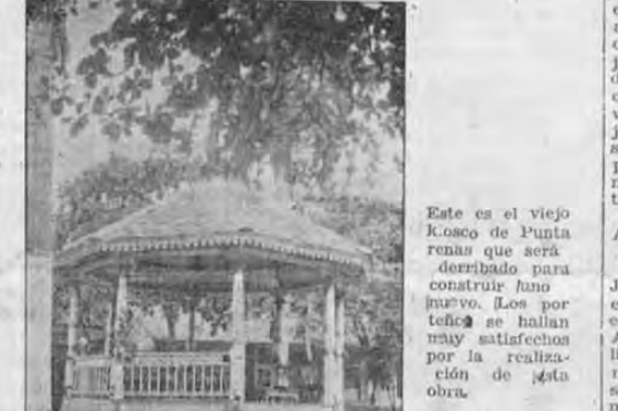
Este es el viejo kiosco de Puntarenas que será derribado para construir uno nuevo.
